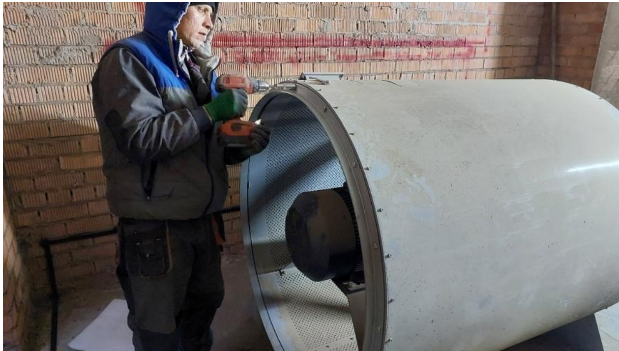
5-сурет - Желдеткішке қарсы фланецті орнату процесі
