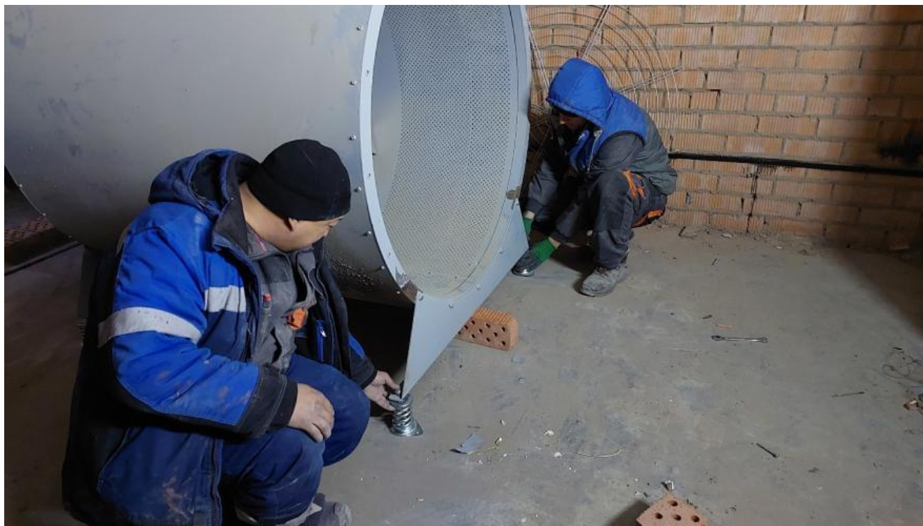
7-сурет - Серіппелі оқшаулағышты орнату процесі
