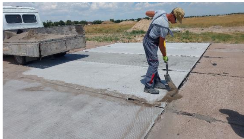
7-сурет - Плиталардың түйіспелі қосылыстарын дәнекерлеу
