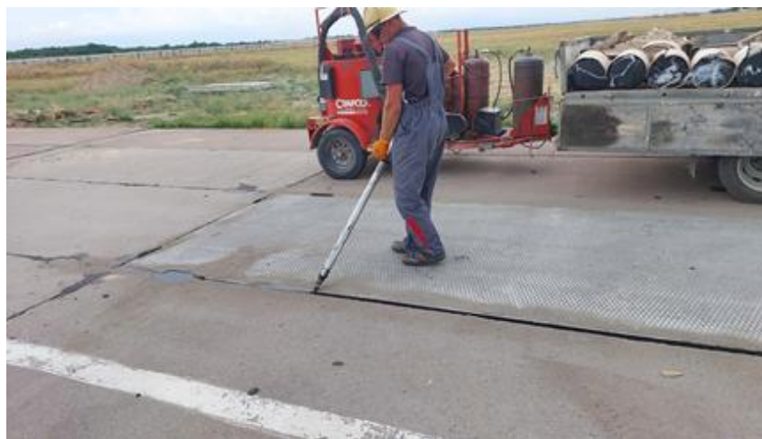
9-сурет - Битумды-полимерлі тығыздағышпен тігістерді тығыздау
