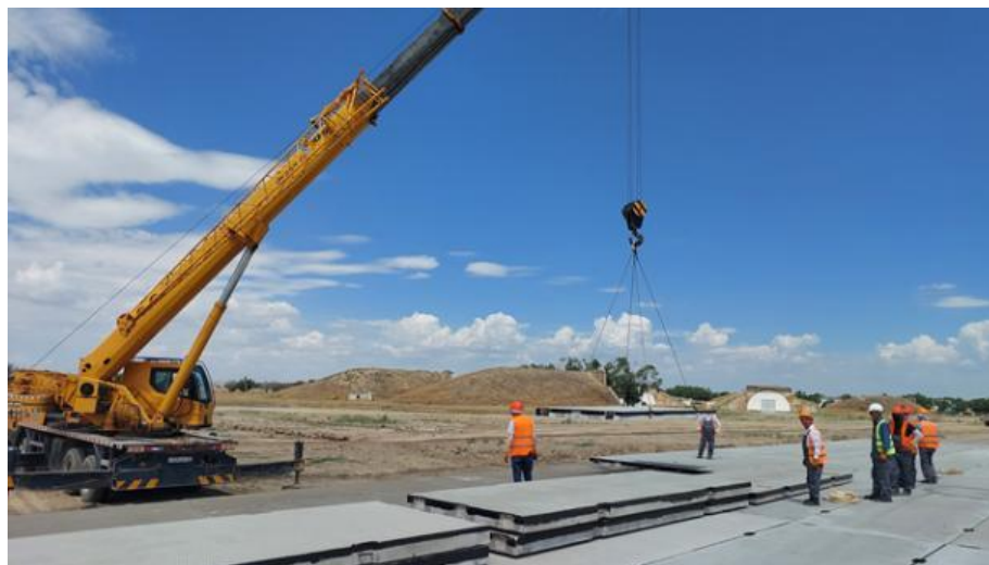
4-сурет – Жол плиталарын төсеу
