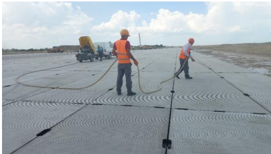
6-сурет – Плиталардың беті мен түйіспелерін тазалау
