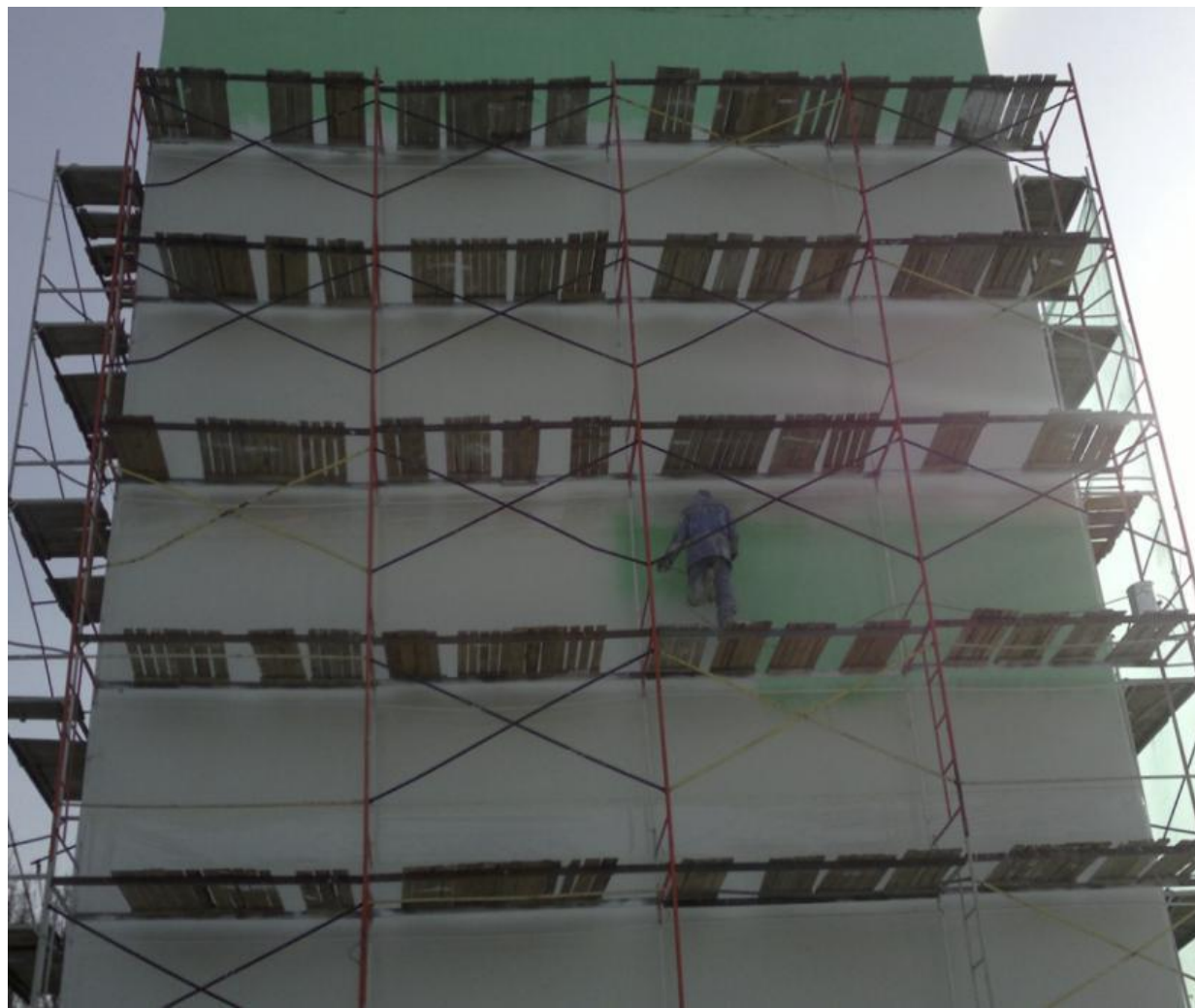
2.2-сурет– Қабырғаларға наножабынды қолдану
