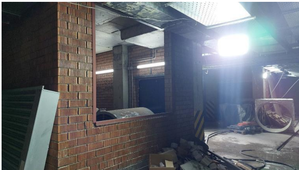
3-сурет - Клапан орнатуға арналған саңылау
