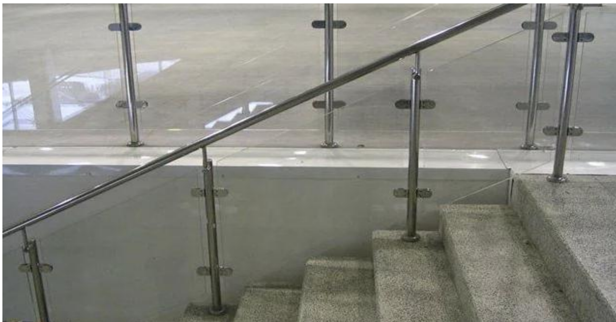
2.7-сурет – Тот баспайтын болаттан жасалған шыны баспалдақ қоршауларының жақтау құрылымы
